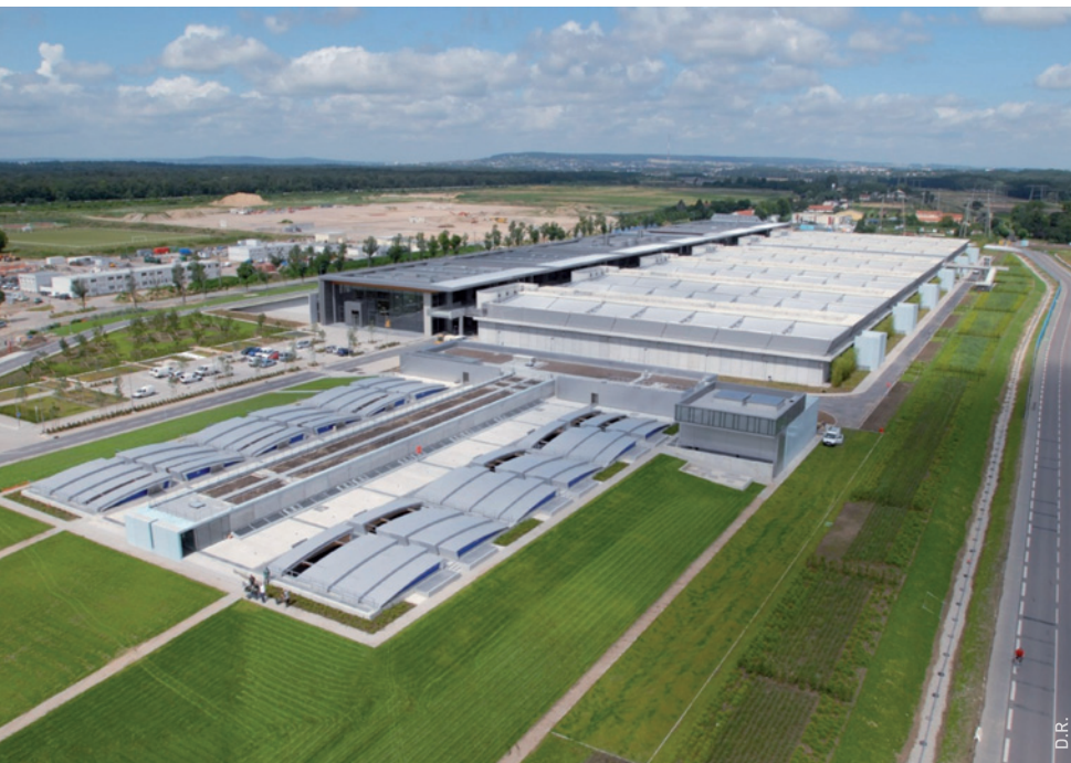
Unité de nitrification de la station Seine Aval
